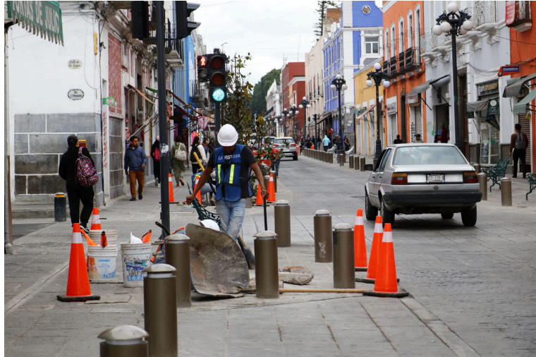
Réduction des voies de circulation sur l'Avenue
